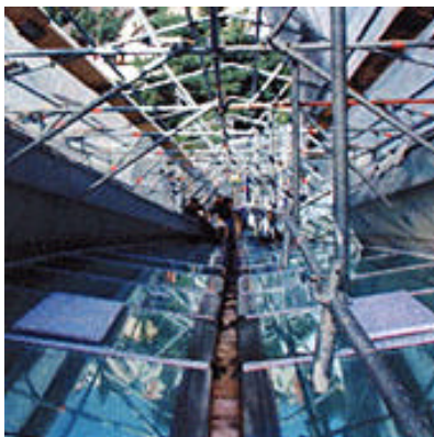
Ausfachen der Glasstösse mit extrudierten Wärmedämmplatten, die Glaserarbeiten erfordern höchste Präzision
