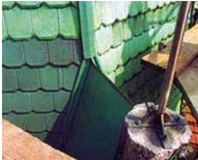
Der Unterschied zwischen neuen und alten Schindeln ist augenfällig. Die Oxyd-Oberfläche macht an der freien Bewitterung diverse Farbstadien durch.
