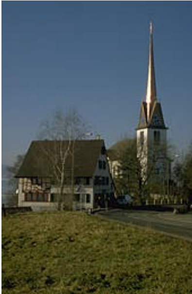
Die Kirche Gossau ZH nach der Renovation im neuen Kleid.
