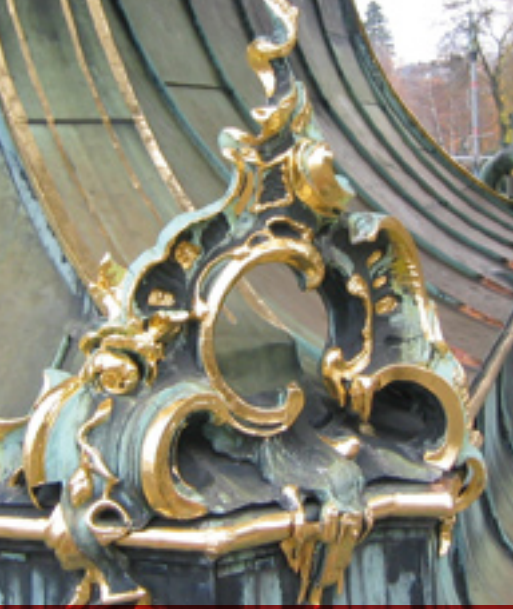
Die Blechornamente in ursprünglicher Dominanz – repariert und neu vergoldet.
