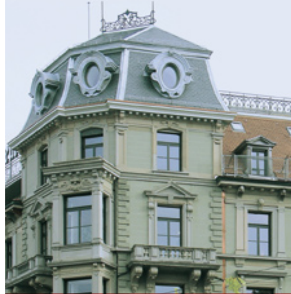
Wo vorher nur noch ein Flachdach war, setzt der Dachaufbau wieder ein Zeichen.
