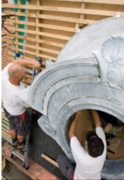
Montage der rekonstruierten Dach-einfassungen aus Zinkblech.
