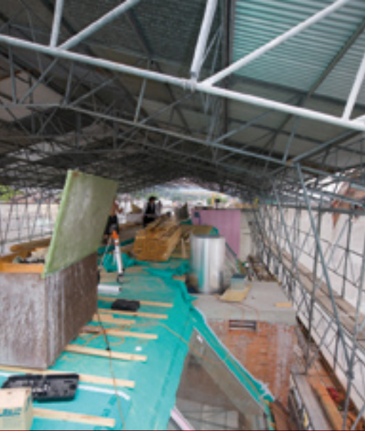
Ein Notdach schützte Handwerker und Baustelle bei den Arbeiten am offenen Dach.
