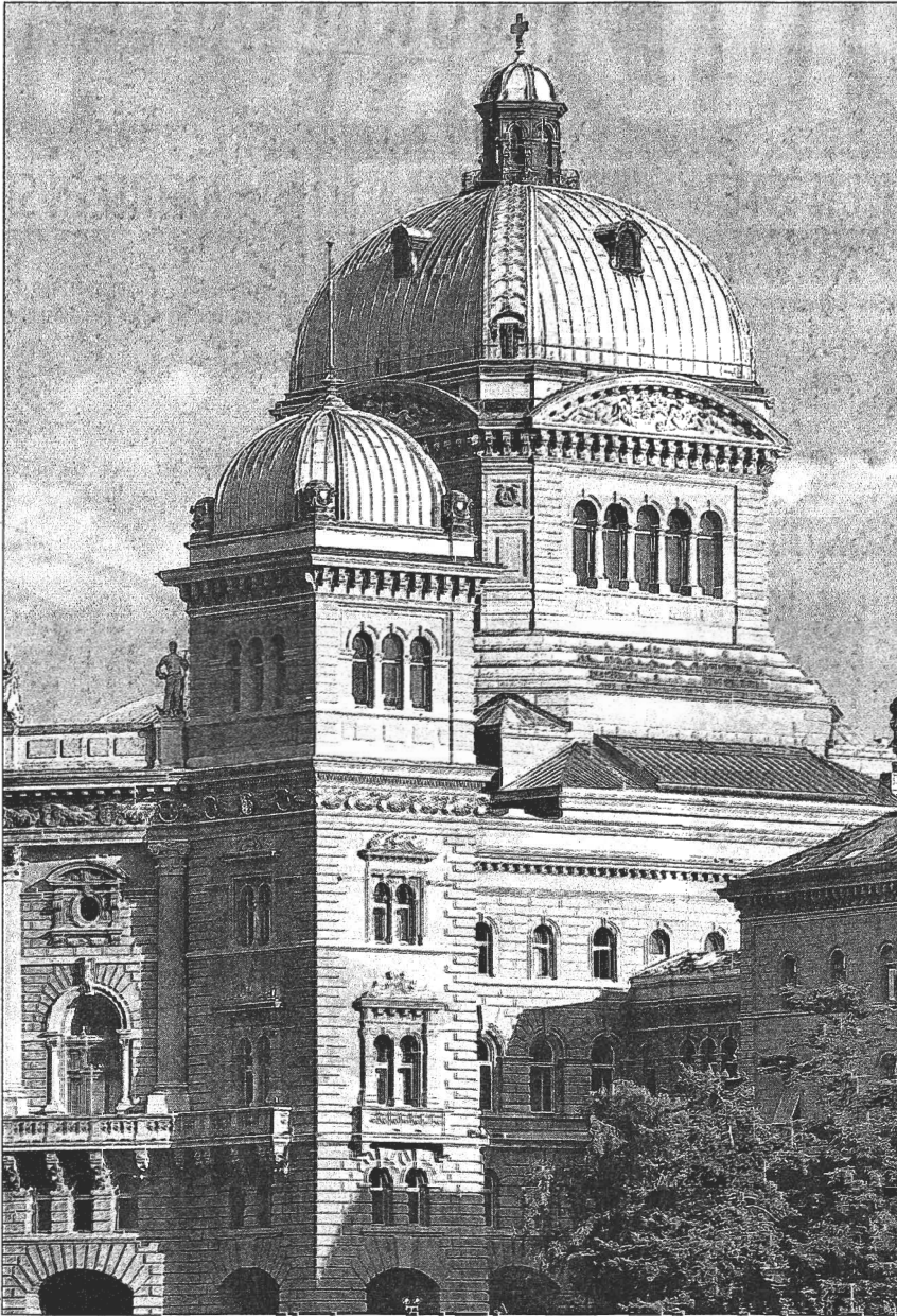
Die drei Bundeshauskuppeln müssen saniert werden. Offen ist noch, ob die Bedeckungen vorübergehend kupferrot glänzen werden.
