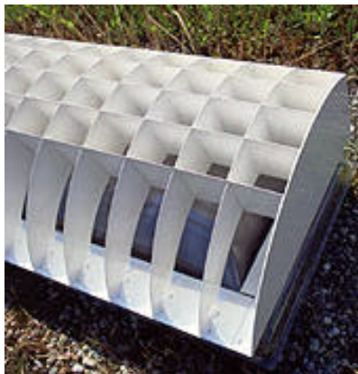
Optimierter Sonnenschutz direkt auf Lichtkuppel montiert (Schulhaus Pfaffechappe, Baden) Lichtplanung: Reto R. Miloni
