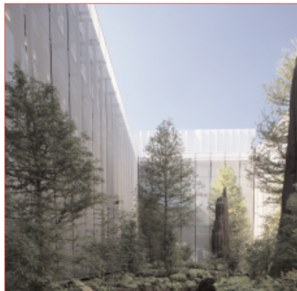
Die Perspektive aus dem Innenhof zeigt die geschuppte Rückseite des Auditoriums auf dem Dach.
